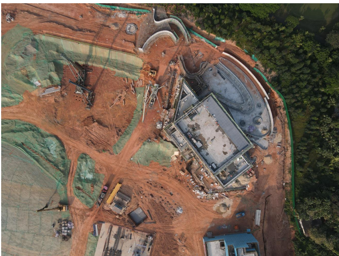
照片 6 项目建筑物施工现状
