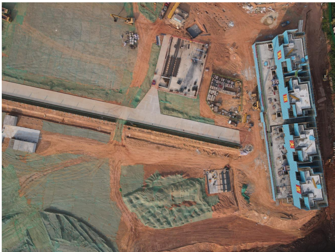
照片 5 项目建筑物施工现状
