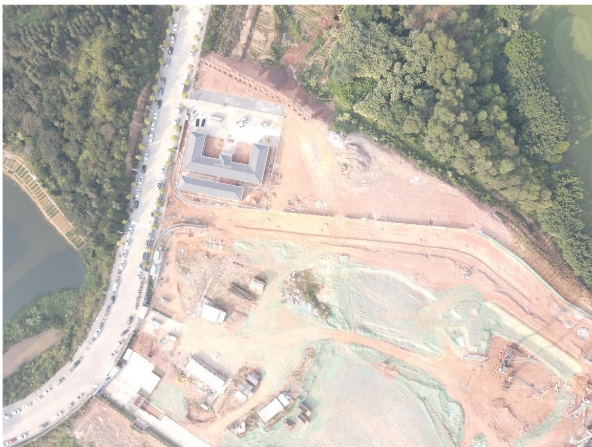
照片 3 项目施工临建区
